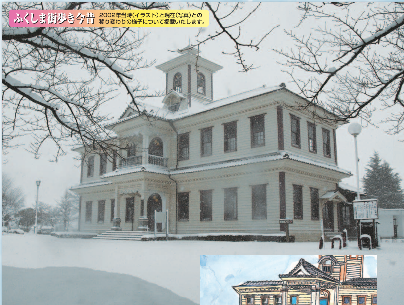
「旧伊達郡役所」 (伊達郡桑折町)
